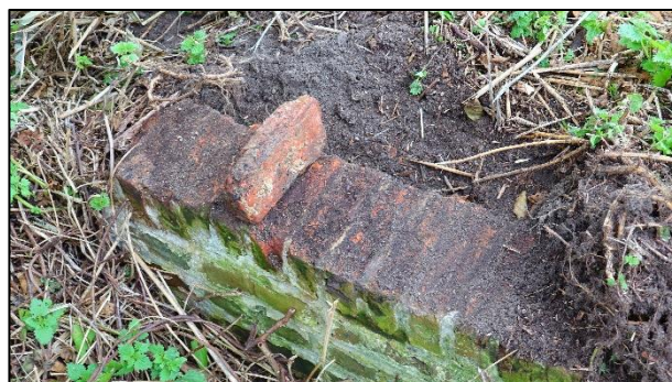
Afdeklaag van de sluis.
